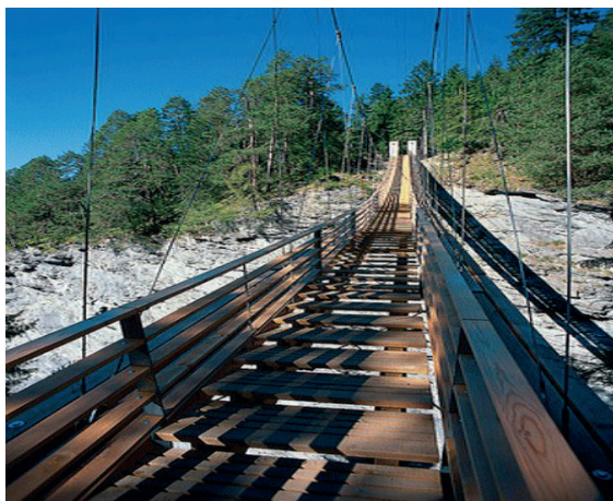
сл. 90. Дрвен мост
