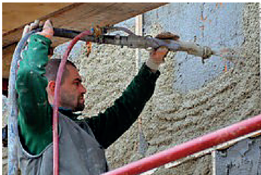
Сл.60 Машинско малтерисување на внатрешни и надворешни ѕидови
