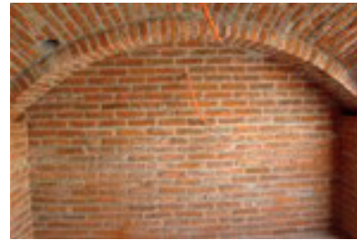
сл. 41 Сид од фасадна полна тула
