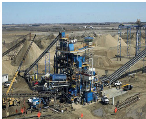
сл.61 Фабрика за бетон
