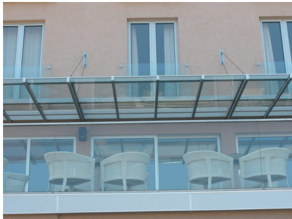
Сл. 69 Покривање на тераси
