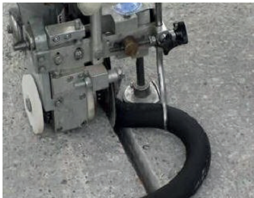
Сл.130 Исполнување на дилатациони фуги кај патишта и железнички пруги
