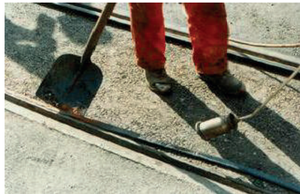
Сл.130 Исполнување на дилатациони фуги кај патишта и железнички пруги
