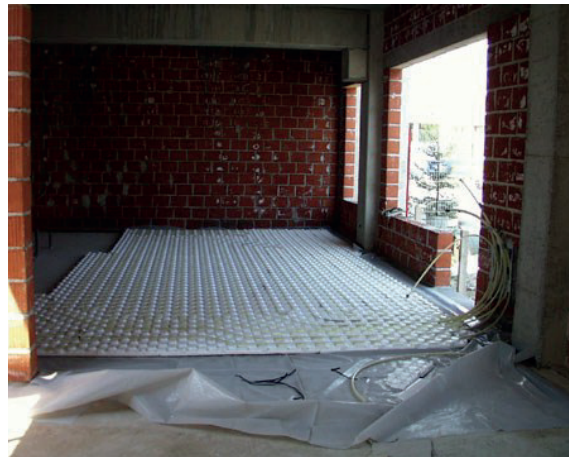
сл. 100 Топлинска изолација на поткровје и на плоча
