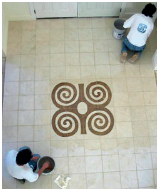
сл. 46 Поставување на подни керамички плочки
