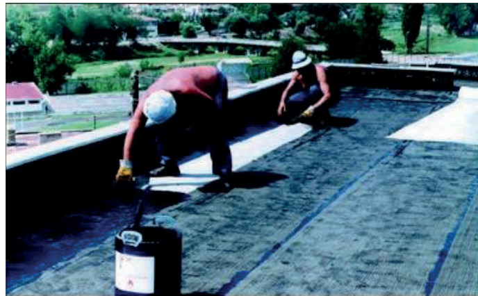
сл. 97 Хидроизолација на тунел Сл.98 Хидроизолација на рамен кров
